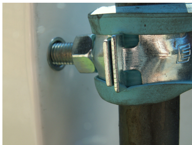
Närbild på infästning mot skåp.
