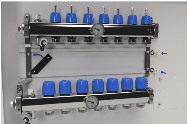
Montage av LK Värmekretsfordelare RF
