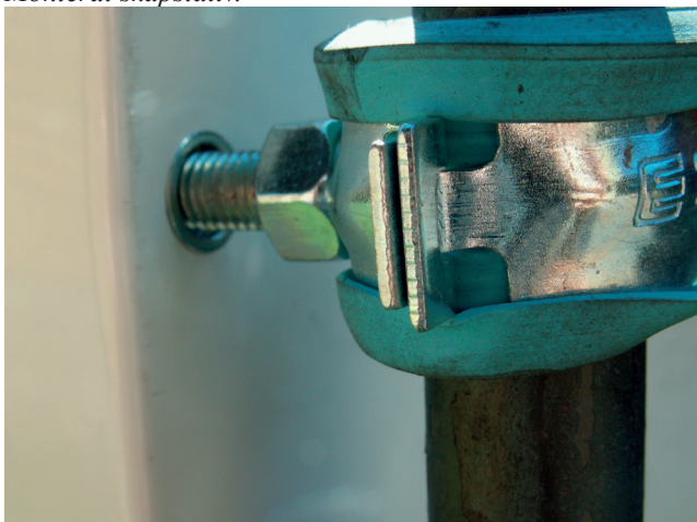
Närbild på infästning mot skåp.
